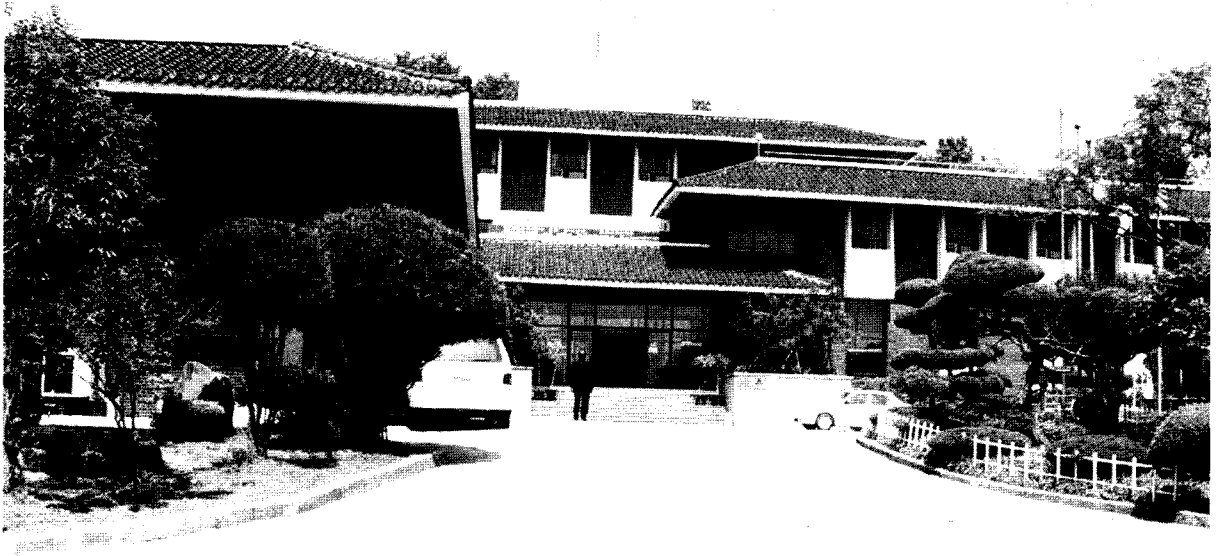
삼정부여 유스호스텔의 전경
